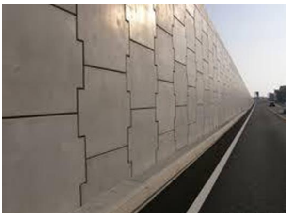
出雲市 テールアルメ工法 コンクリートスキン
