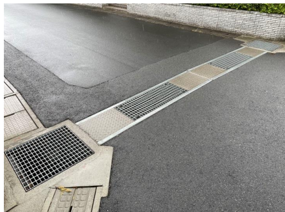
出雲市 白枝町 自由勾配側溝「CH-Ⅱ(横断型)」
