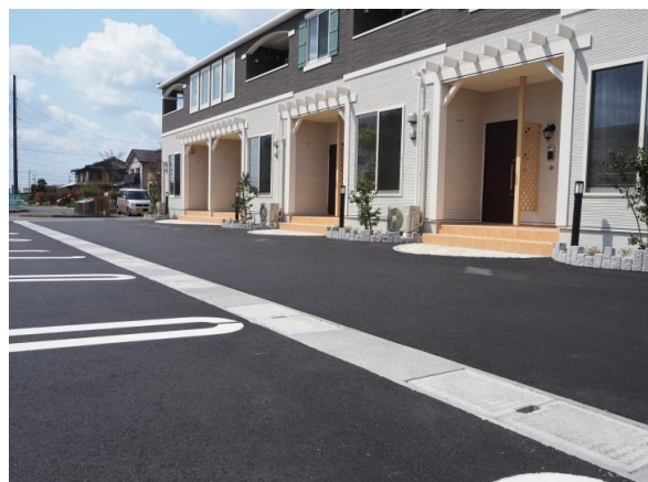
出雲市 斐川町 自由勾配側溝「CH-Ⅱ・オトム」
