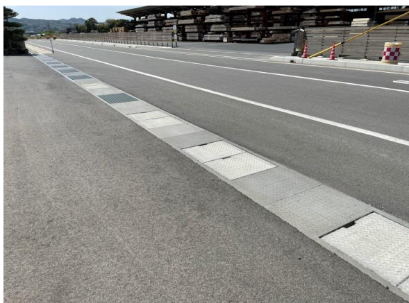
出雲市 高松町 自由勾配側溝「CH-Ⅱ・オトム」
